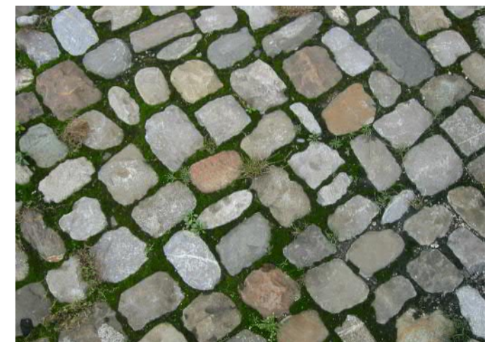
Pflasterungen mit offenen Fugen bieten Lebensraum für Pflanzen und Tiere und haben den Vorteil, dass das Regenwasser vor Ort versickern kann.
