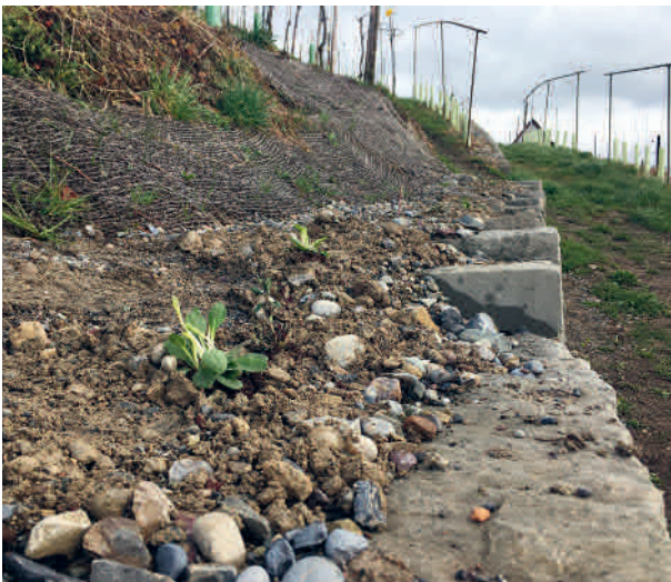
Begrünung Trockenmauerbau Klevnerweg (9.970)
