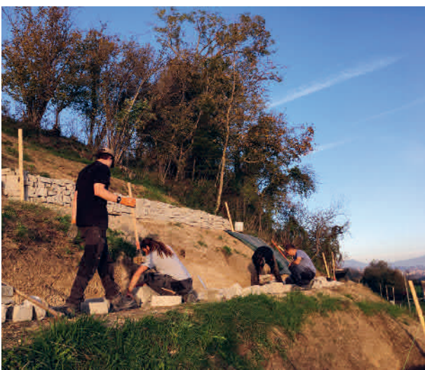
Erstellung Trockenmauern Auenhof (4.886)
