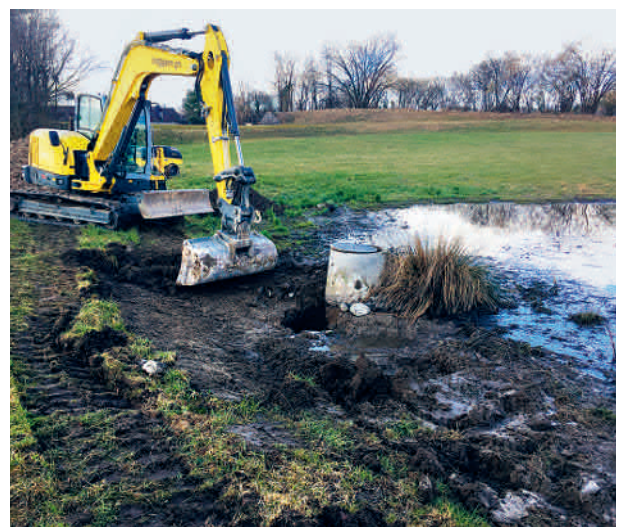
Reparatur Schacht und Stau einrichtung (7.944)
