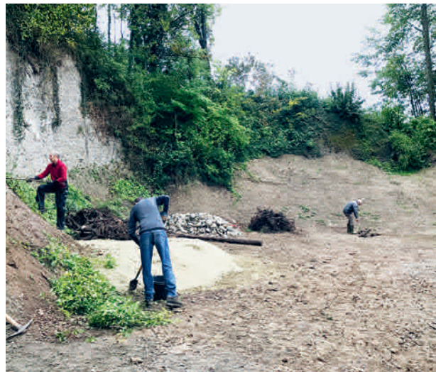
Arbeitseinsatz Grube Rhynerstrasse (9.977)
