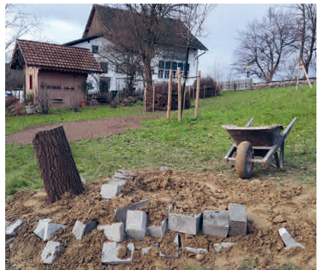
Bau Wildbienenstandort Chilenrain (8.961)
