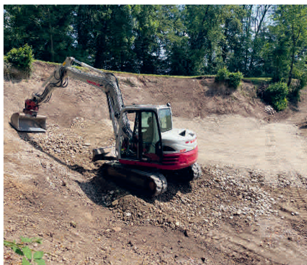
Bauarbeiten Aufwertung Kiesgrube (4.927)
