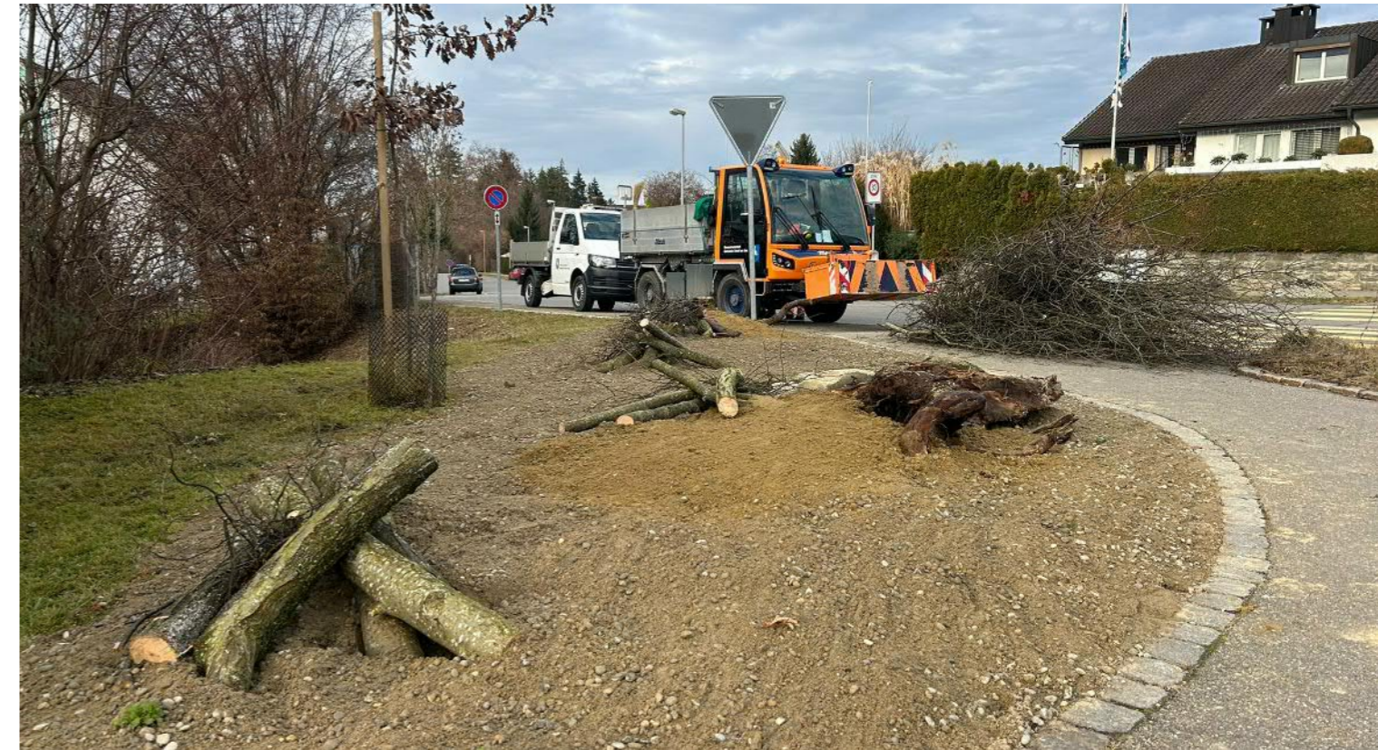
Fläche nach Fertigstellung (8.968)
