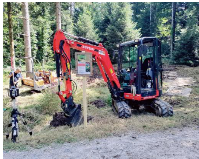
Vorbereitungen für den Bau von Stauwehren und Weihern (6.969)
