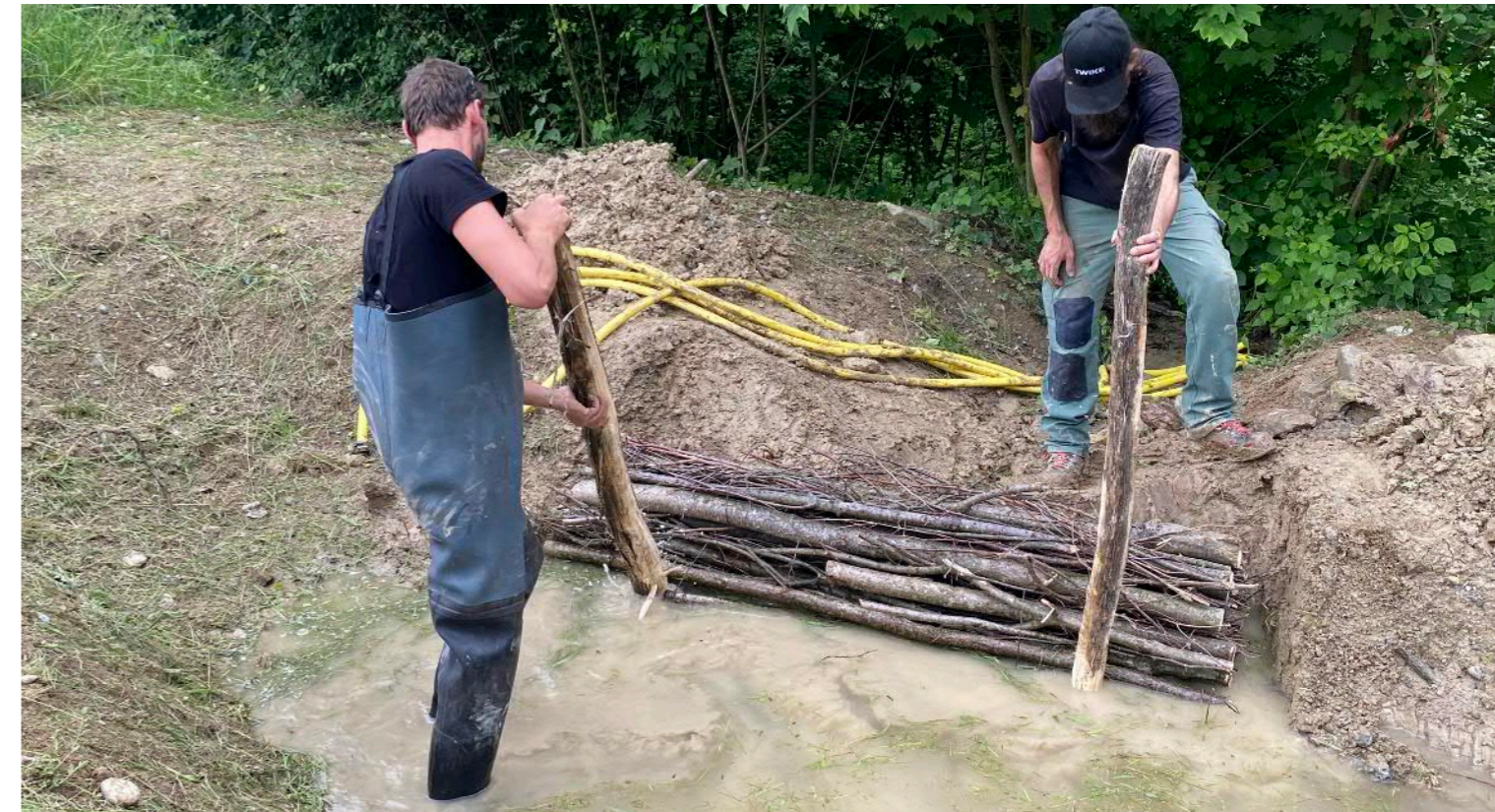
Einbau der Faschinen zur Sicherung des Weiherauslaufs (10.997)
