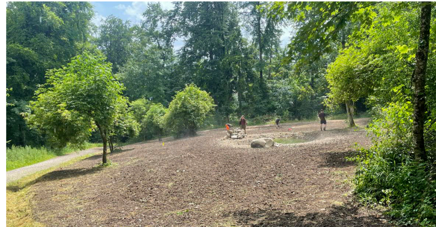
Bodenvorbereitung für Direktbegrünung (7.947)
