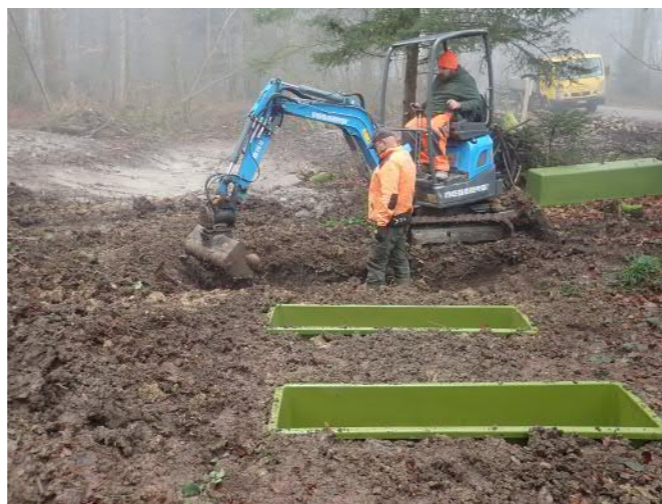
Einbau neuer Unkenwannen und Teichbau (9.961)
