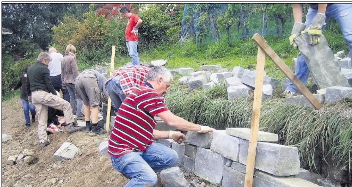
Etwa einen Meter hoch bauten die Freiwilligen die Mauer.
