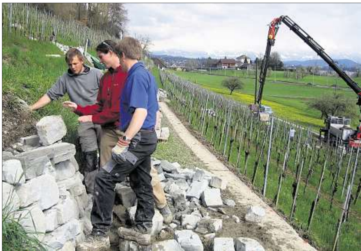
Trockenmauerbau bei Feldbach. Zivildienstleistende halfen mit.
