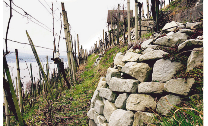
Die Trockenmauern in der Ueriker Risi haben eine ideale Stützfunktion.
