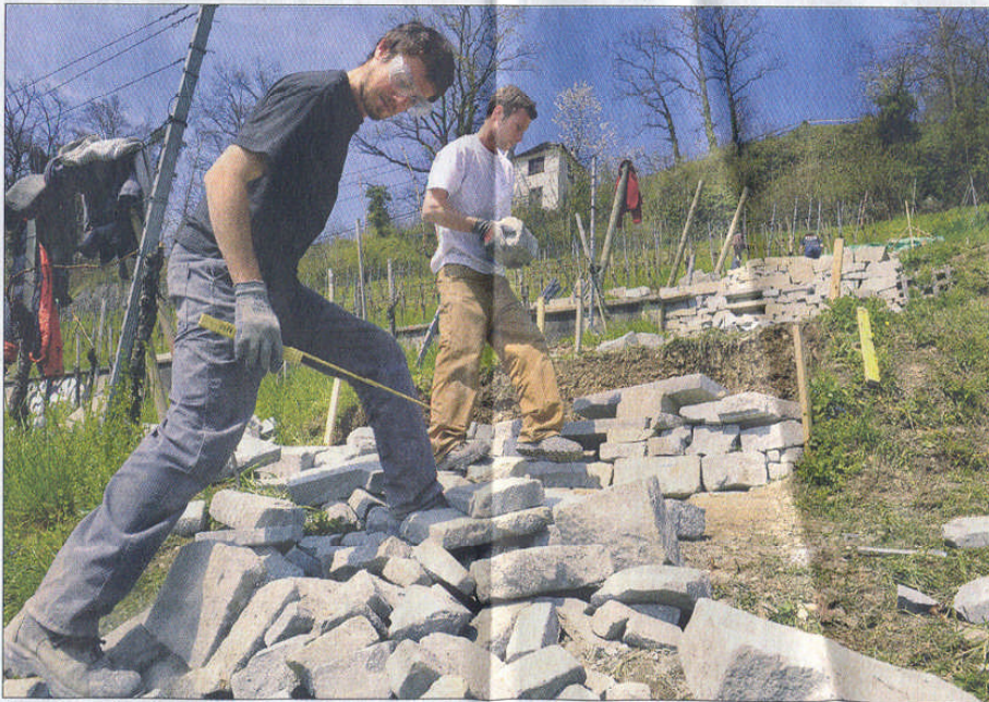
Knochenarbeit im Dienste der Schlingnatter – Zivildienstleistende bauen eine Trockenmauer. KARIN HOFER
