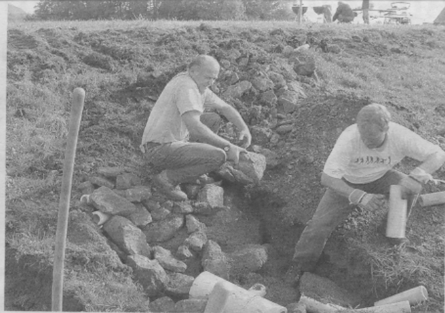
Die Drainage unter der «Reptilienburg» ist äusserst wichtig, damit das Wasser abfliessen kann
