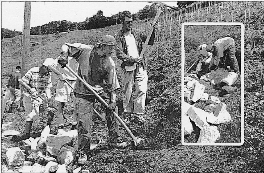
Zahlreiche Helfer waren am regionalen Naturschutzaktionstag mit von der Partie, so etwa Peter Müller (im Vordergrund, links), Fachmann in Sachen Reptilien, und Rebbauer Philip Gfeller (rechts). Gebaut wurden etwa zwei Trockenmauern als Unterschlupf für die Reptilien. Gerda Lingler
