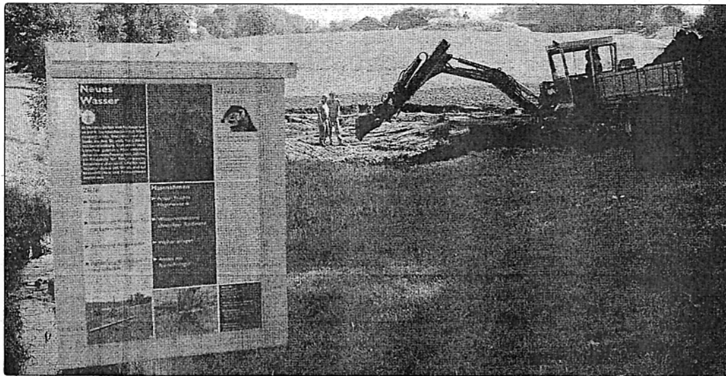
Ein Schild informiert über die neuen Gewässer im Sandacher, während die Aushubarbeiten laufen. Anna Moser
