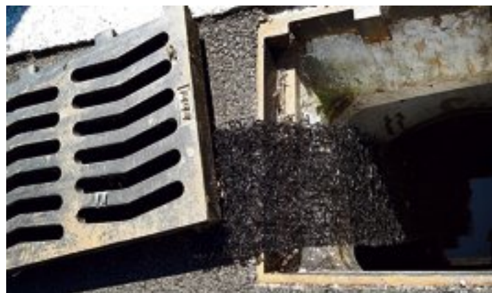
Notausgang für Amphibien: Mit Hilfe von Kunststoffmatten können sich auch kleine Tiere selbstständig aus Strassenschächten befreien.
