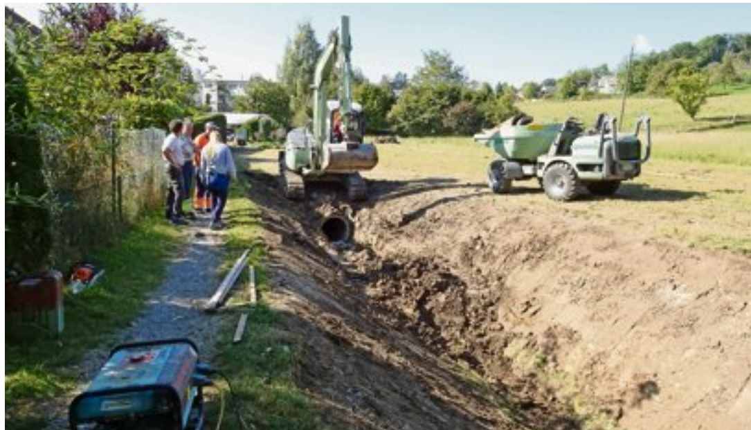
Arbeiter versetzten den Klingenbach mit schwerem Gerät in seinen natürlichen Zustand zurück.
