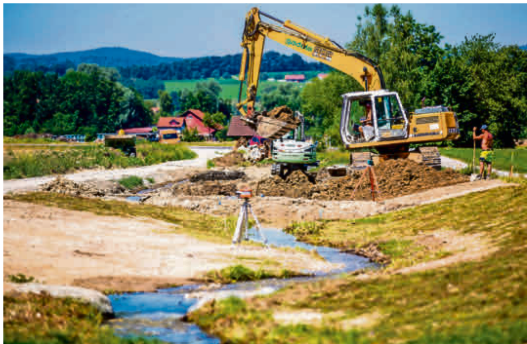
Arbeit auf Hochtouren: Ein Bachabschnitt des ehemaligen Bluntschlibachs in Egg wird aktuell aus unterirdischen Rohren ausgehoben, um danach wieder natürlich fließen zu können.
