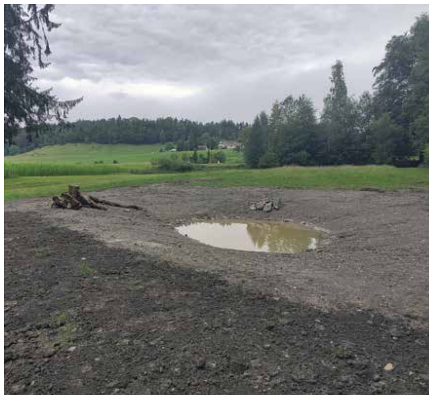
Der fertige Weiher – es fehlt nur noch das Wasser.
