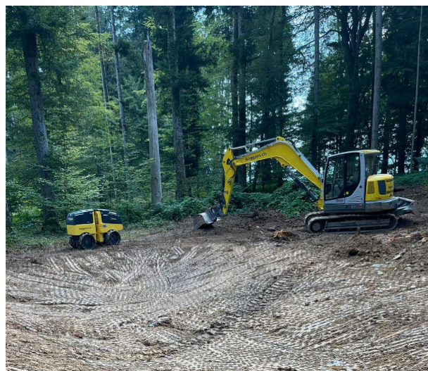
Weiherbau Alter Stuckiweg (10.976)
