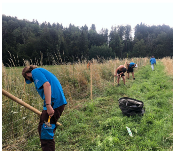
Bau eines Hecken-Schutzzaunes Niderwis (5.948)
