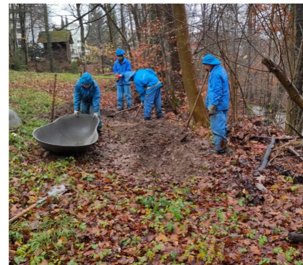
Einbau von Unkenwannen am Zollikerberg (11.971)
