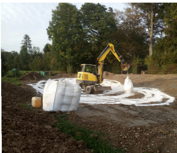
Bagger bringt Stabilitkalk für Weiherbau aus (8.999)
