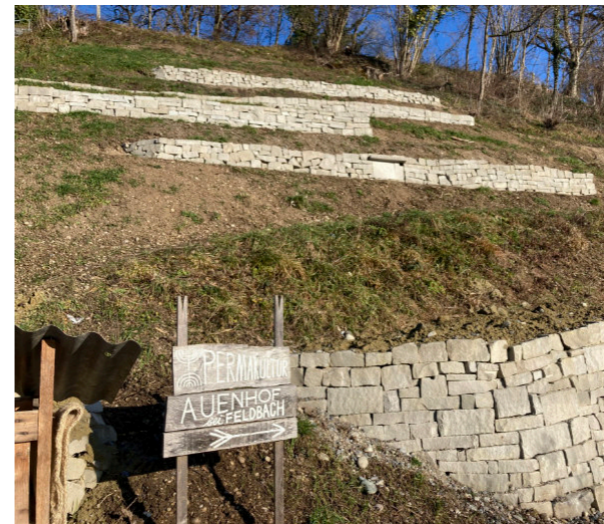
Fertiggestellte Trockenmauern am Auenhof (4.886)
