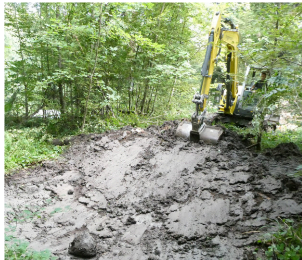
Baggereinsatz für neuen Weiher im Rappentobel (1.925)
