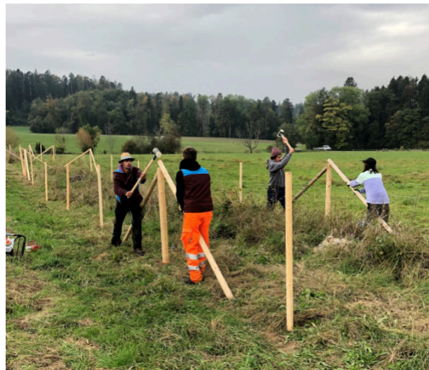
Bau eines Heckenschutzes am Würzbrunnenbach (3.966)
